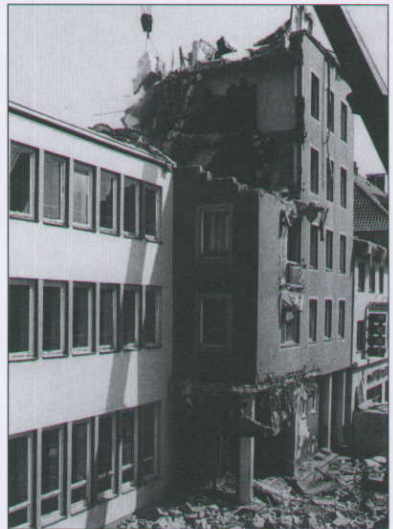
1987: Die Badehalle muß dem Kreis- haus weichen und wird abgerissen
