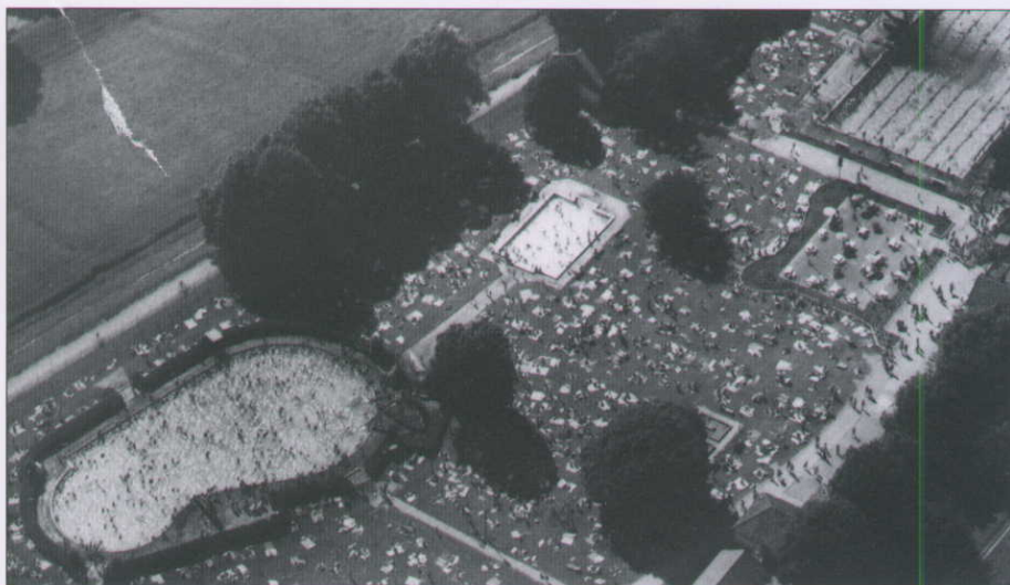
Die Jowi von oben mit 50-m-Sportbecken, Kinderplanschbecken und Nichtschwimmerbecken
