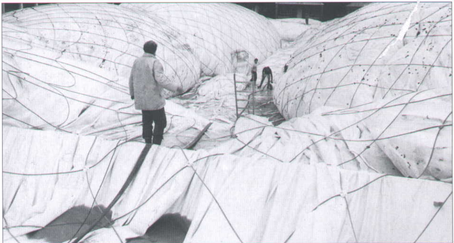
Aufbau der Traglufthalle auf der Jowi 1987/88
